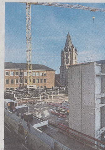
Die Baustelle vor dem Rathaus
