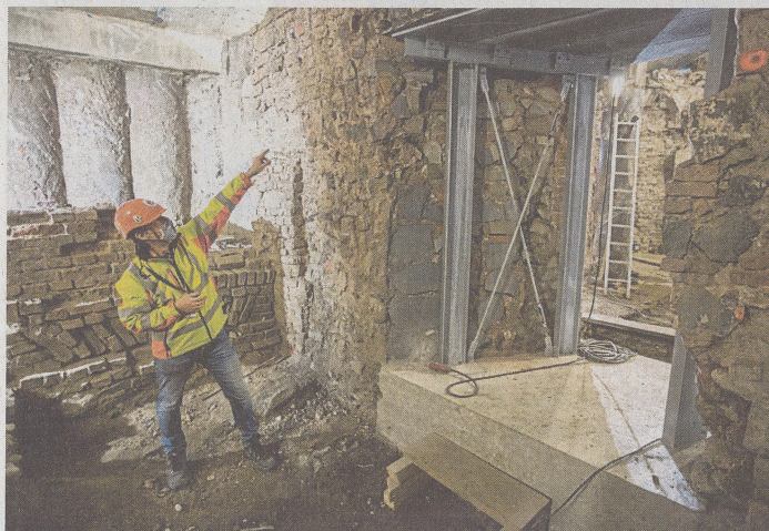
Stahlträger stützen die alten Mauern.
