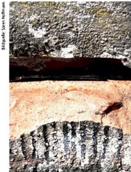
Abb. 7: Mindestüberlappung von 10 Zentimetern der HD-Polyethylen-Platten
