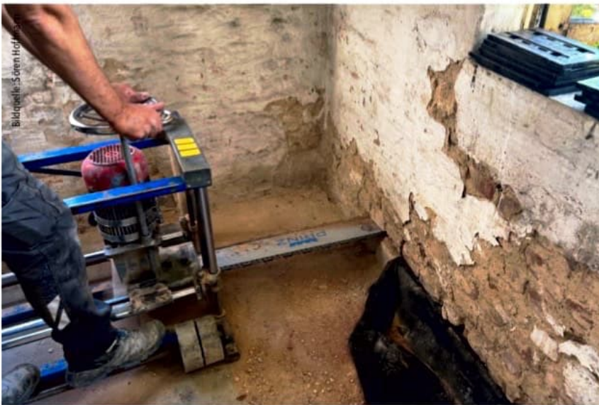
Abb. 4: 20 Millimeter Hartmetallsägekette zum Sägen von Mauerwerksfugen
