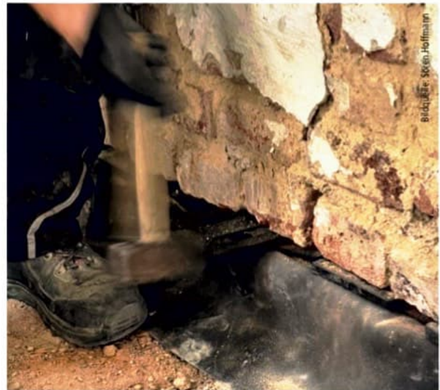
Abb. 8: Kraftschlüssiges Einschlagen von passenden Mauerwerkskeilen mit einem Hammer (maximal 1,5 Kilogramm) über den gesamten Querschnitt der Mauer in Abständen von 25 Zentimeter (jeweils gemessen von der Mitte des Mauerwerkskeils).
