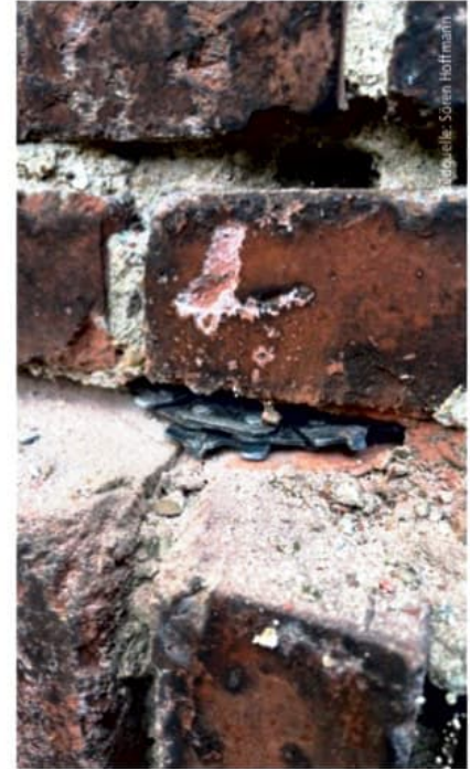
Abb. 4: 20 Millimeter Hartmetallsägekette zum Sägen von Mauerwerksfugen
