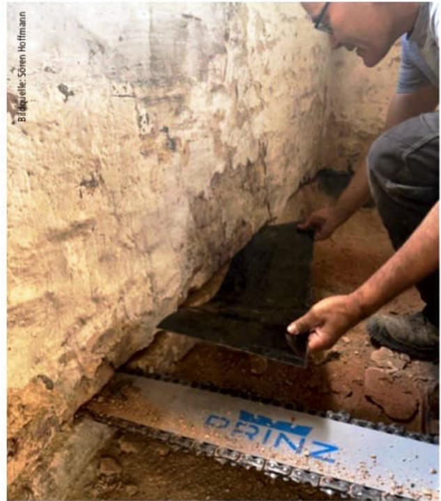
Abb. 6: Einlegen der HD-Polyethylen-Folie als Sperrmaterial
