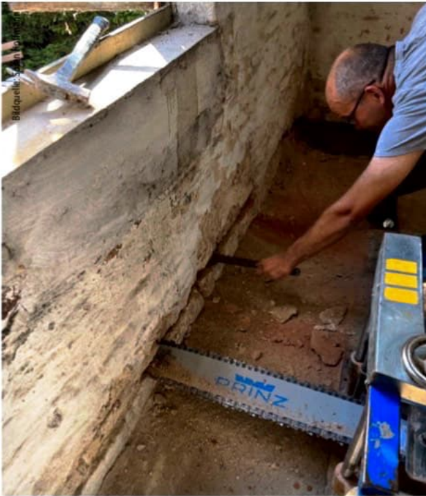
Abb. 5: Reinigen der Schnittfuge von letzten Rückständen in Form von kleinen Steinen mit dem Fugenreinigungsmesser
